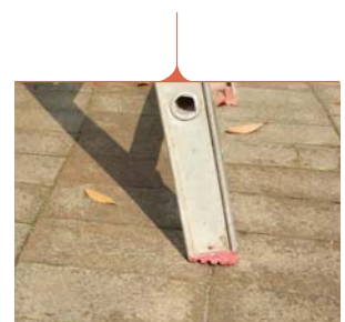
이동식 사다리 하부 미끄럼방지 장치(A형으로 설치 시)
